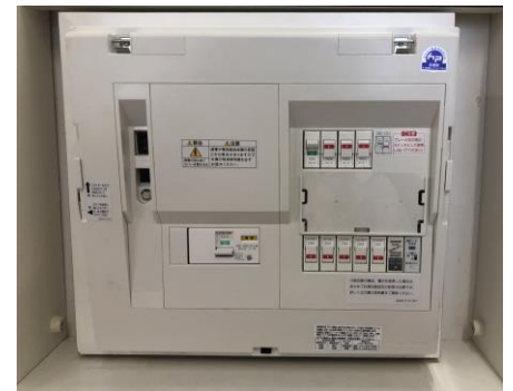
地震による電気火災に有効な 感震ブレーカー
