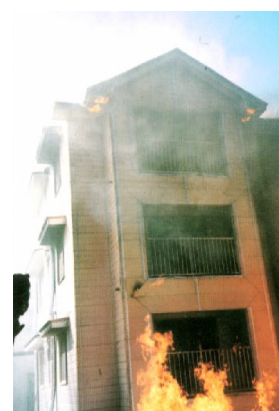
木造共同住宅の火災実験
