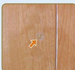
パテは乾燥すると肉やせするので、一度乾燥させた後に塗り重ねる。木工パテは2色程度しかないので、乾燥し完全に固まった後にマニキュアタイプの補修剤を塗って色を合わせたり、木目を描く。
