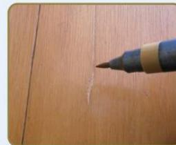
補修剤は数種類の色があるので、床の色に合わせて選ぶ。木目を出すには、色を複数用意して、薄い色を塗った後に木目を描く。必ず目立たない場所で試し塗してから補修する。
