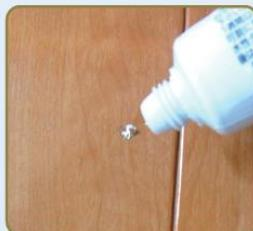
補修箇所の汚れをよく落として乾燥させた後、木工パテを直接絞って補修箇所に塗り込む。ヘラで傷にパテを埋め込み、はみ出した余分なパテはヘラでかき取ってから、濡れ布できれいにふき取る。
