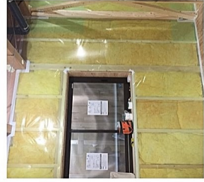
断熱で最も大事な窓と隙間なく敷き詰められた断熱材
