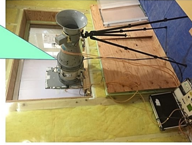
気密測定器で性能を測っている様子
