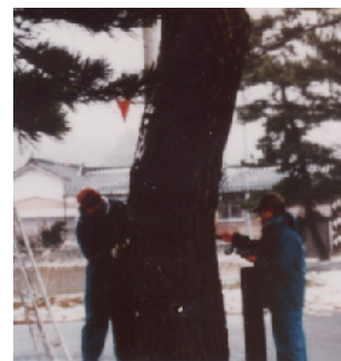
樹木の劣化診断
